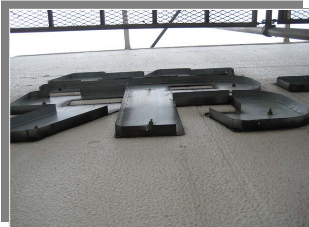
広告塔既存チャンネル文字撤去
