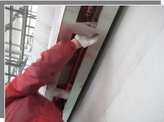
1Fランマ看板FL交換状況
