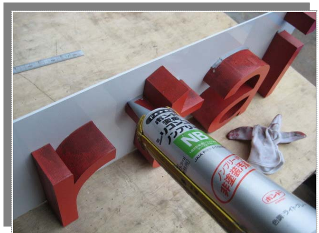
チャンネル文字(小)ベース板取付
