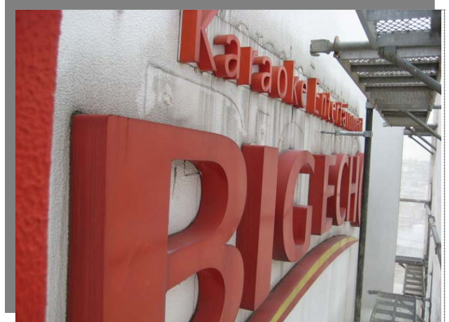
広告塔既存チャンネル文字撤去
