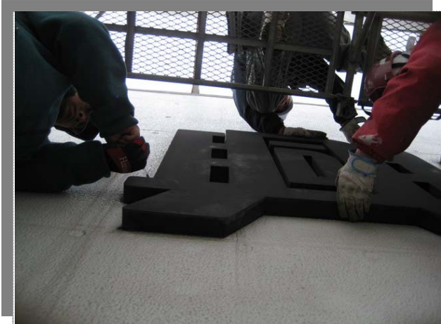
広告塔既存チャンネル文字撤去
