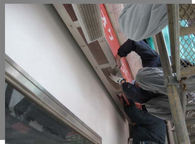
1Fランマ看板FL交換状況
