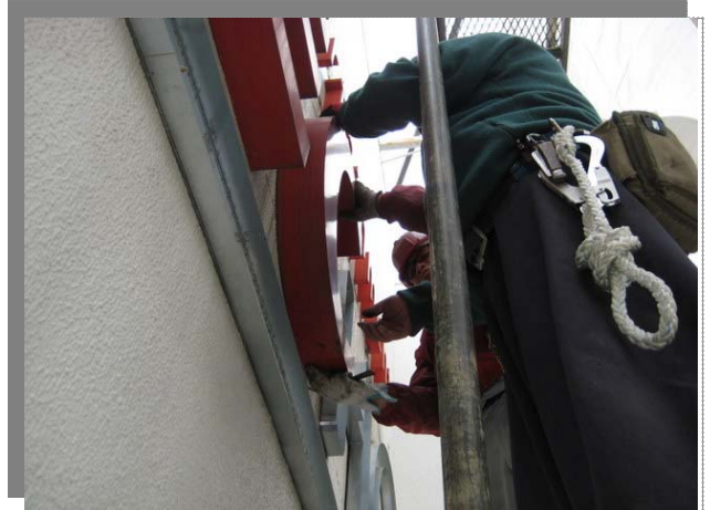
広告塔既存チャンネル文字撤去
