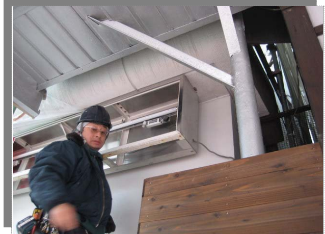
1Fランマ看板FL交換状況
