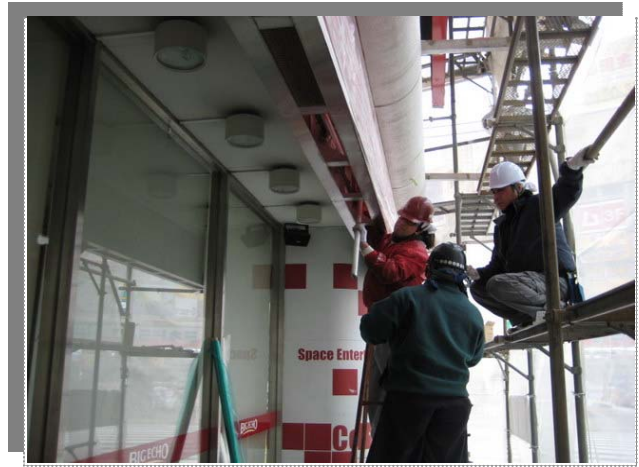
1Fランマ看板FL交換状況
