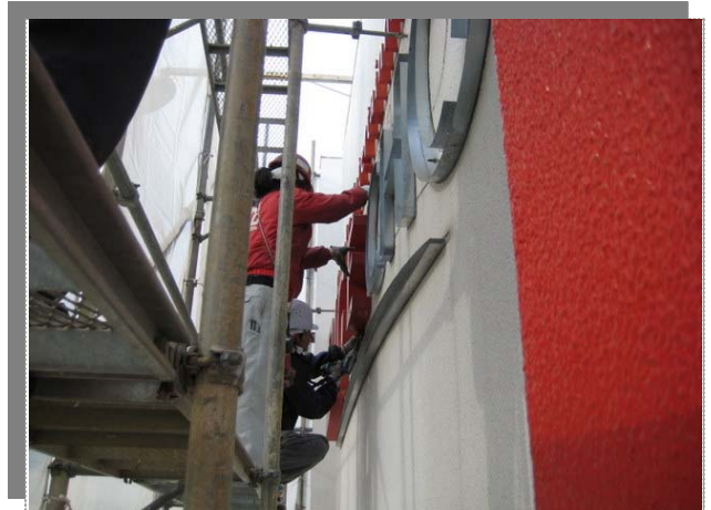
広告塔既存チャンネル文字撤去
