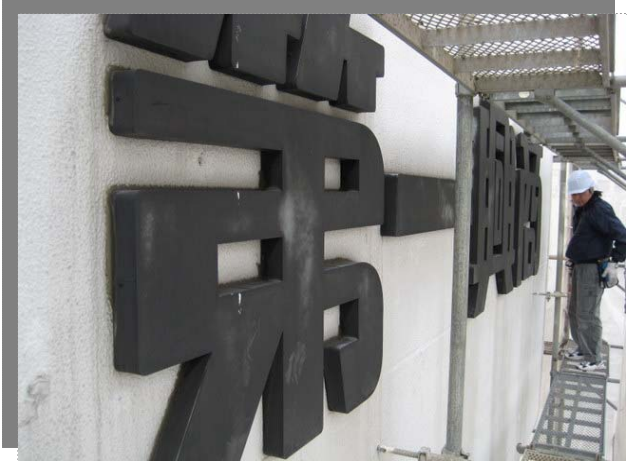
広告塔既存チャンネル文字撤去
