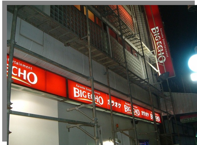
足場組立状況
