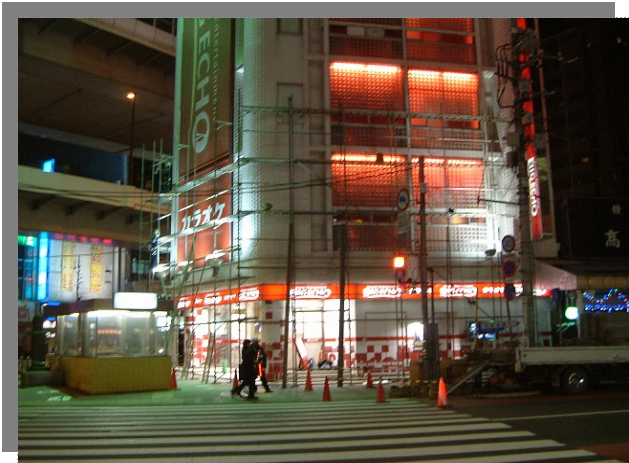
足場組立状況
