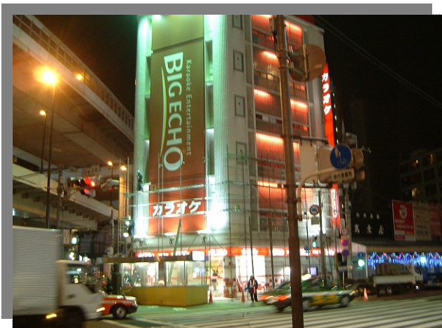
足場組立状況
