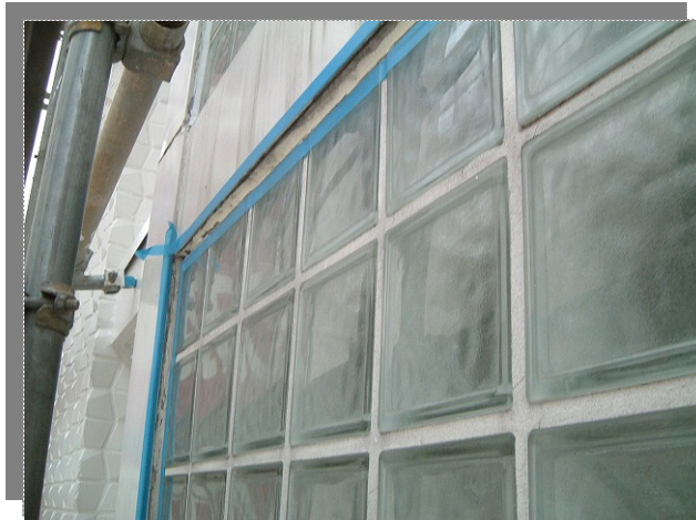
シール打ち状況
