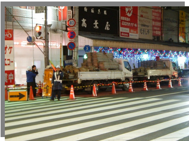
足場組立状況
