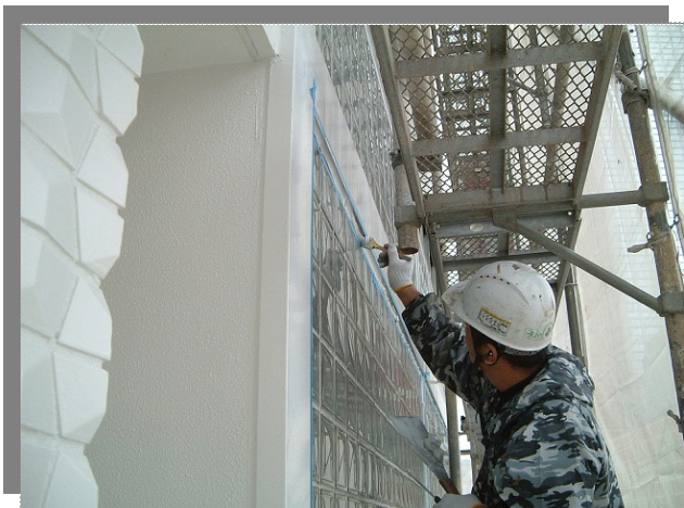
シール打ち状況
