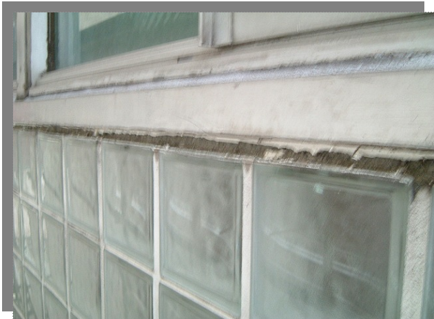
既存シール撤去状況
