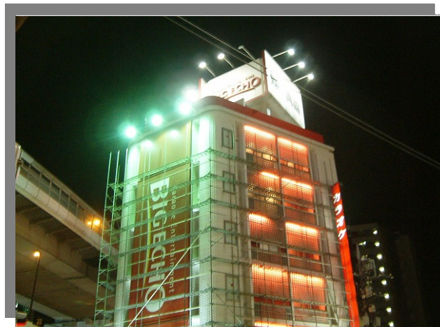
足場組立状況
